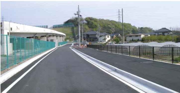
外かん矢切改良その6工事
