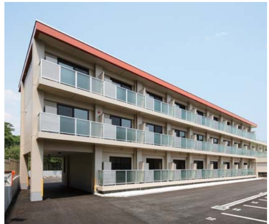
(仮称)西町单身寮新築工事
