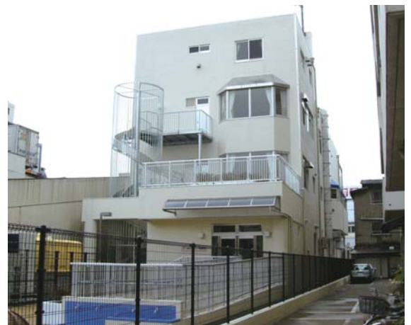
江東区東雲地区保育園(仮称)改修工事
