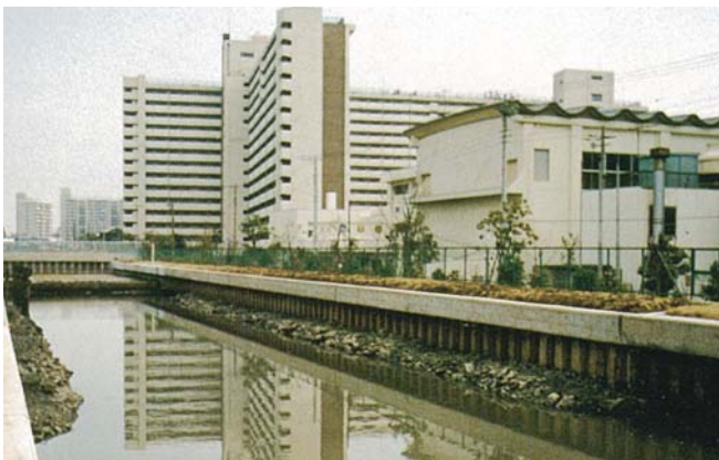
横十間川右岸嵩上防災工事
