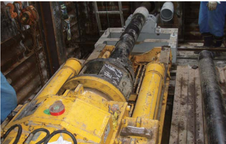
秦野伊勢原環境供給工事(管路)
