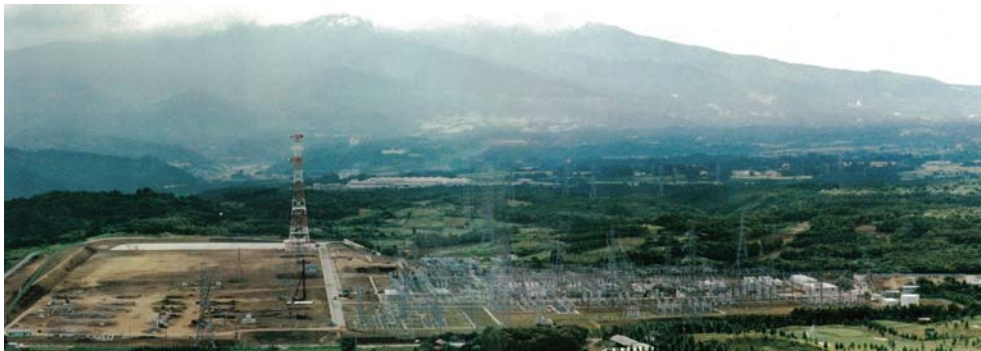
新富士(変)敷地造成工事
